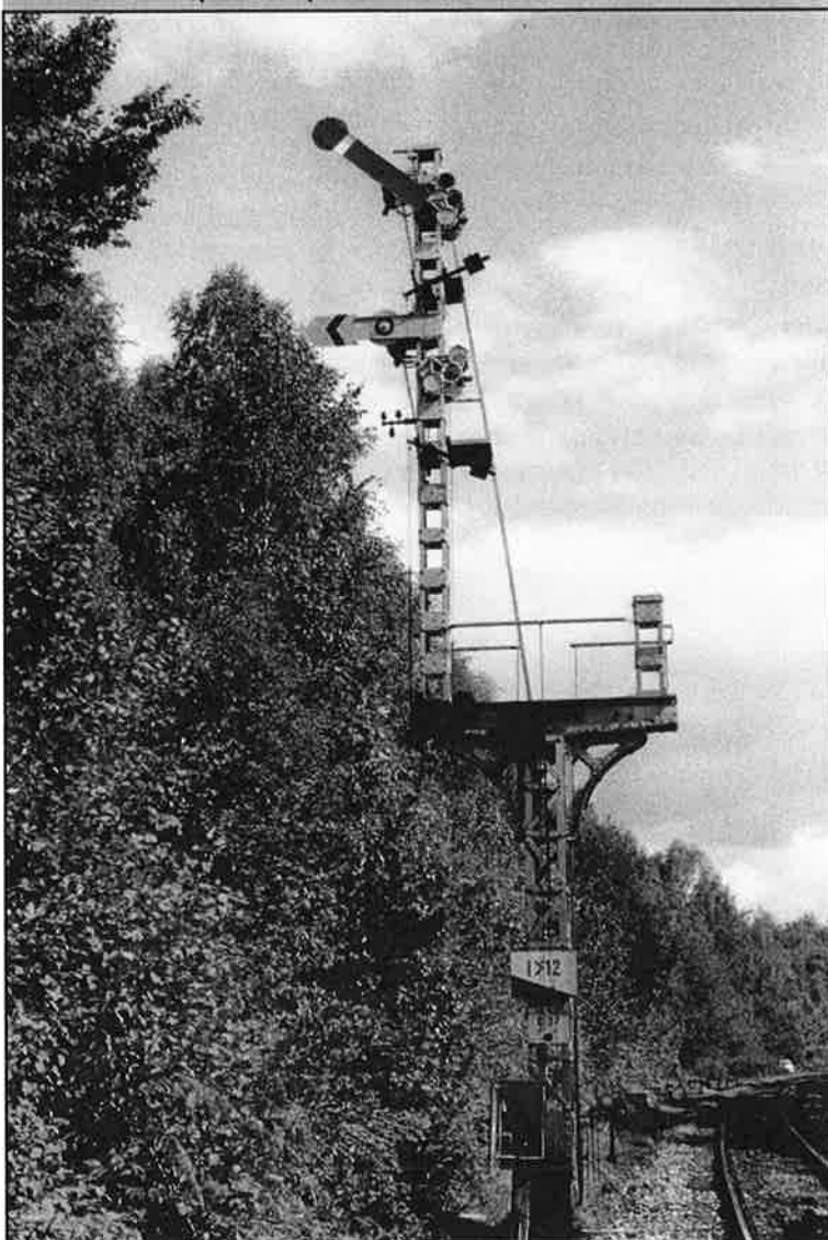
Amputé d'un de ses mats à la suite de la suppression de la voie déviée, voici le chandelier d'entrée de la gare de Saint Vincent - Bellefontaine, côté Florenville (photo Jacques Quoitin).
